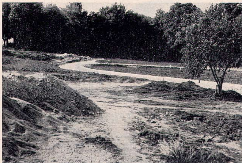
Das Gelände nach zweimonatiger Arbeitszeit
